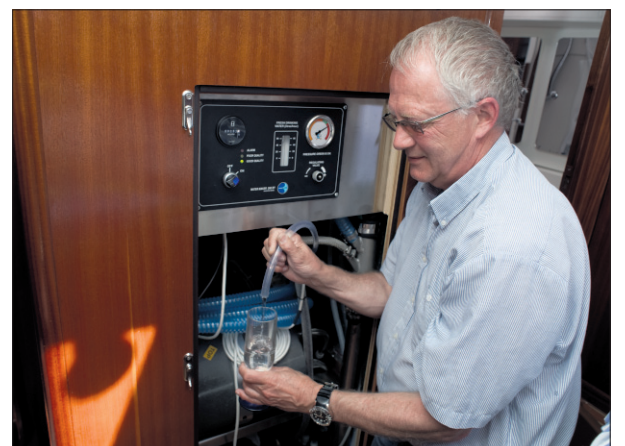
VANN: Per Mandt viser maskinen som gjør om saltvann til drikkevann slik at de alltid har drikkevann tilgjengelig.
