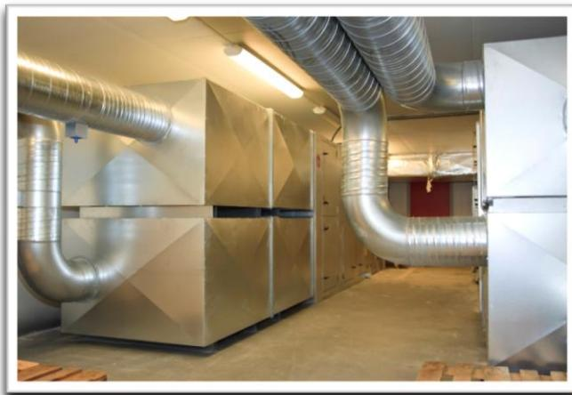
Bilete viser eit balansert ventilasjonsanlegg frå Rommetveit skule, som vart oppgradert for ca. 5 år sidan. Stord kommune har til saman 100 slike anlegg, som krev jamleg tilsyn og oppfølging. Anlegga har energigjenvinning der inntil 75% av varmen vert gjenvunne og styrt av ei sentralt driftskontroll.
