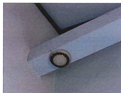
Bilde 7: 4,5 meter opp til ventil vanskeliggjør rengjøring
