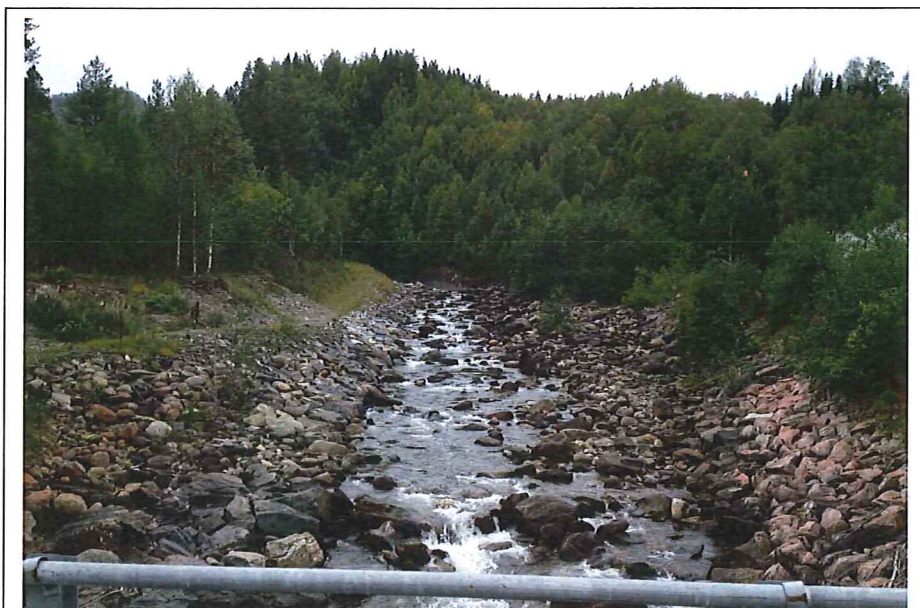
Figur 7: Elveforbygginger anlagt i og langs Russåga, oppstrøms sett fra broen over elven.
