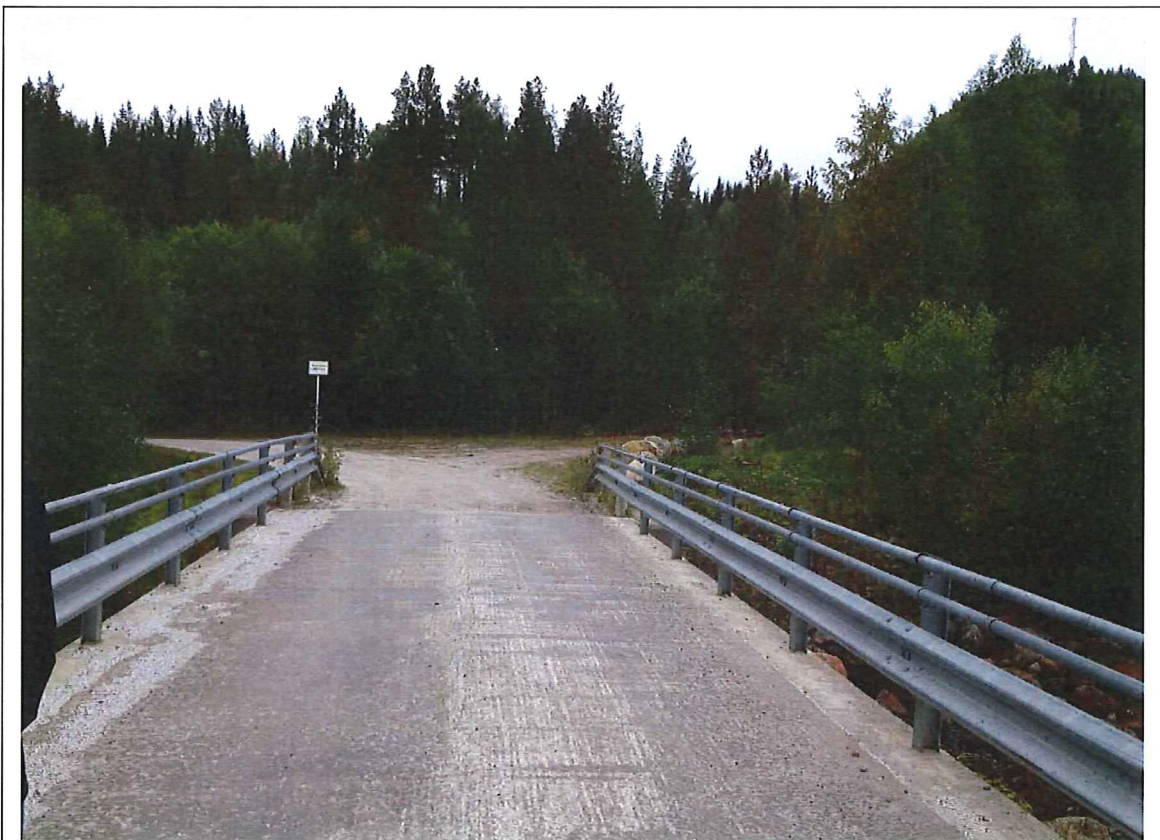
Figur 3: Broen over Russåga, sett mot sør. Privat veg mot venstre, veg til Russånes Vannanlegg mot høyre. Grunnvannsbrønnen B3 (jf. Figur 9) drøyt 25 m fra enden av broen, langs vegen til høyre.
