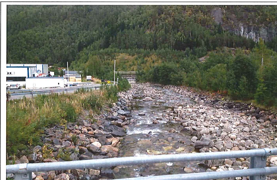
Figur 8: Elveforbygginger anlagt i og langs Russåga, nedstrøms sett fra broen over elven.
