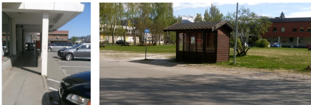
Fortauet har knekk forbi butikkinngangen, og ved holdeplassen er det ikke høydeforskjell som letter av- og påstigning (foto Rambøll)
