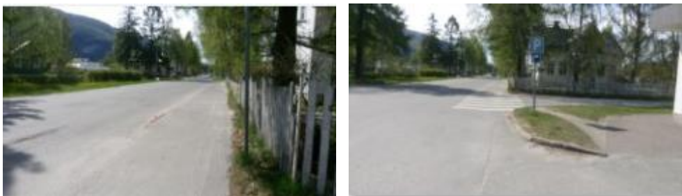
Fortau "forsvinner" før krysset på sørsida. På nordsida er kantstein avrundet nordover ca 3 meter for langt vest (foto Rambøll)
