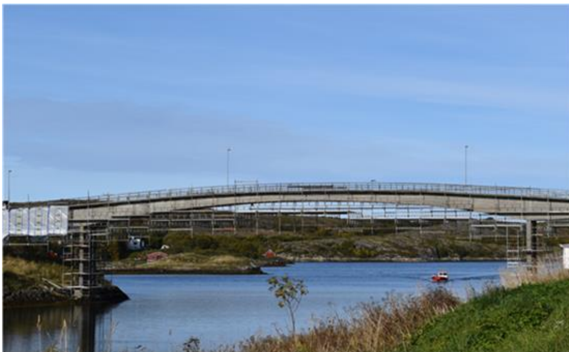
Gamle Herøysundet bru under vedlikehold sommeren 2020
