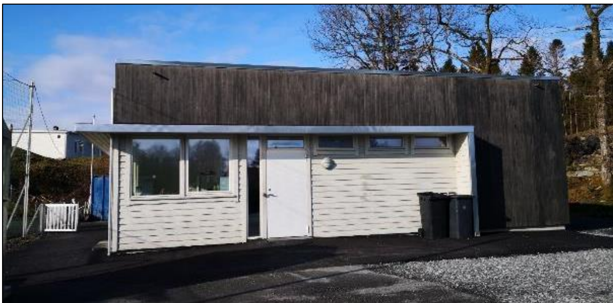
Idrettsbygg/garderobebygg på gnr. 43, bnr. 115.
