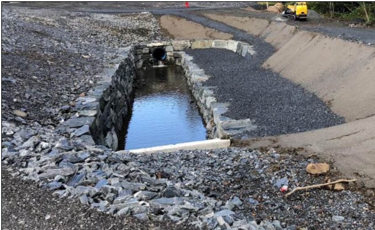
Bilete frå nybygd 800mm og open bekk tilrettelagt for skulen. Gangvegen til skulen i bakgrunnen.
