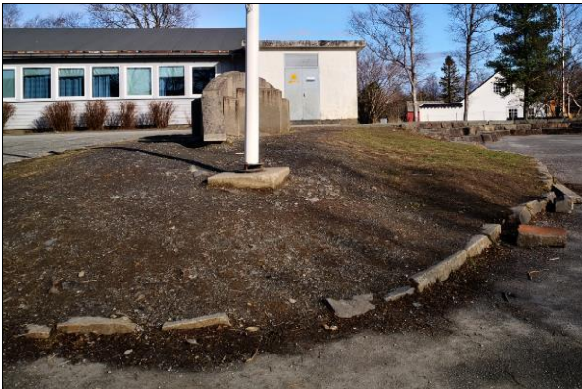
Delar av uteopphaldsarealet til Langeland skule, sett mot nord. Slitt/lite vegetasjonsdekke og øydelagde asfaltkantar syner at område er mykje eksponert for tråkk og leik.
