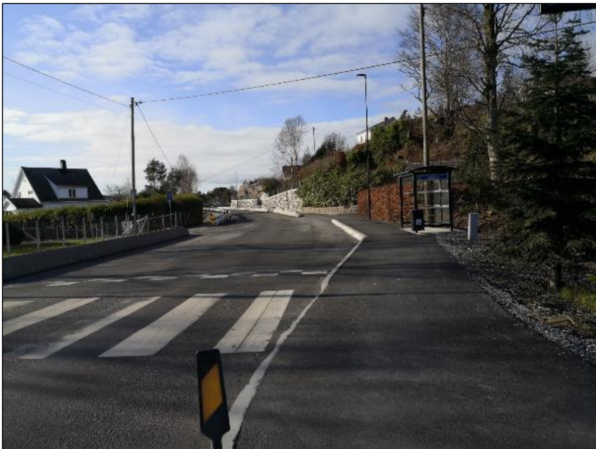
Nytt fortau og busshaldeplass langs Langelandsvegen, mot Heiane.
