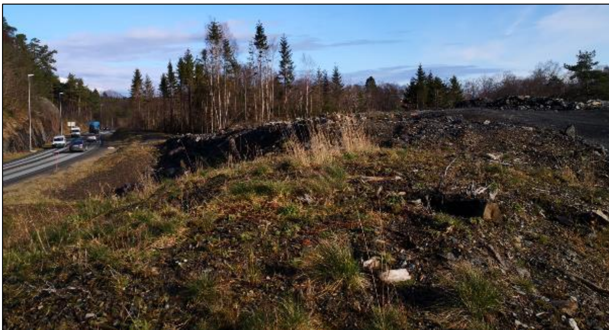
Massedeponi langs E39 med steinmassar som skal fyllast i våtområde og trer lenger nord.
