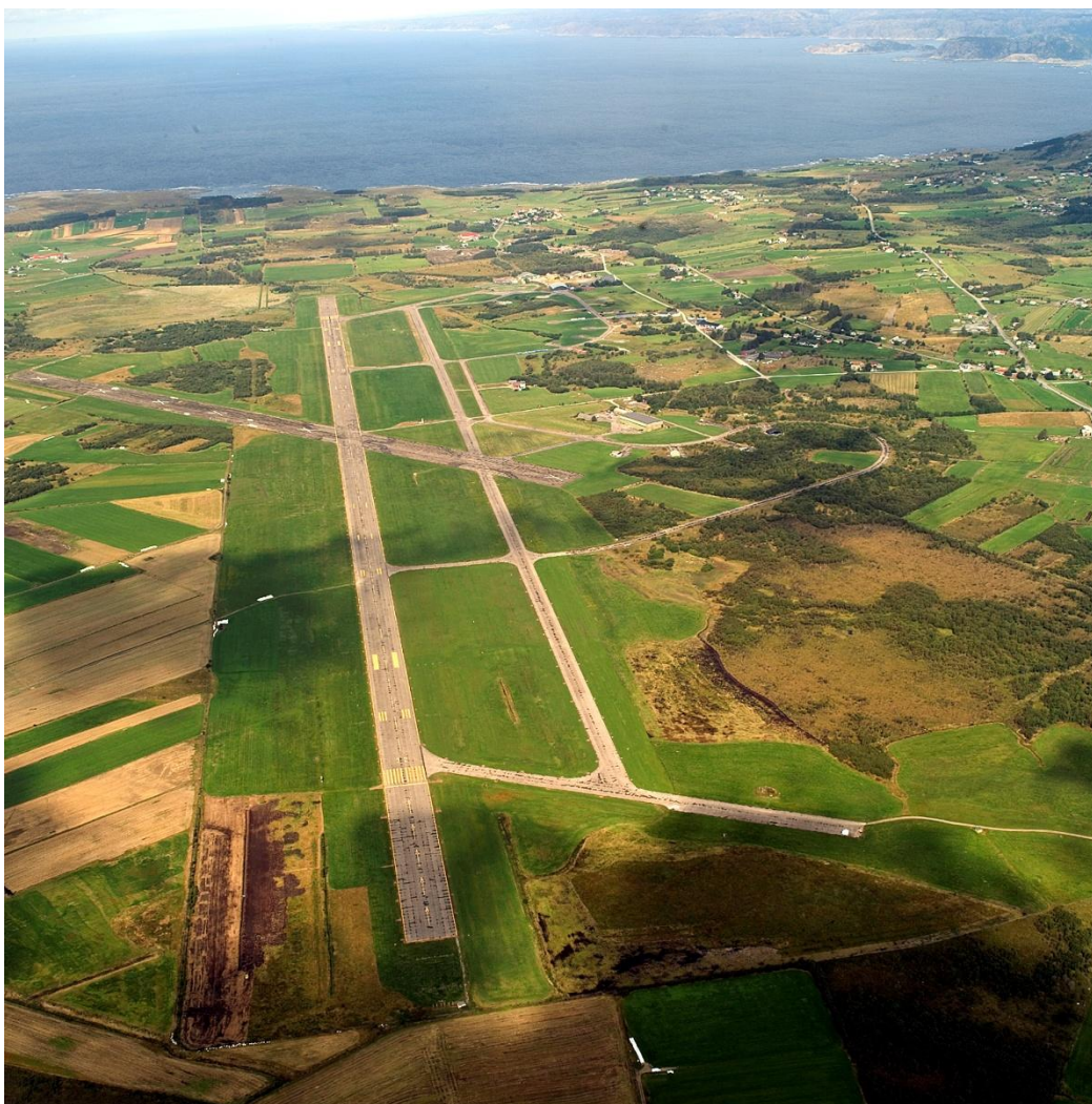
Flyfoto fra øst - planområdet er i høyre del av foto. Flyfoto Terrateknikk as - Tor Kviljo 2014
