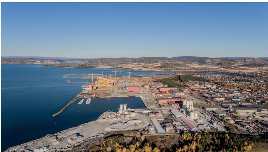
Verdal Industripark. Kilde: Verdal Næringsforum
