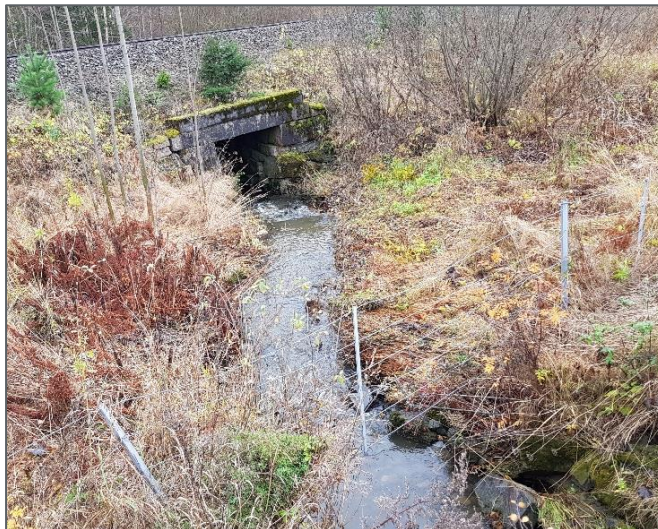
Figur 20: Kulvert ved Bekkefare ved avkjøring til Fv. 284.
