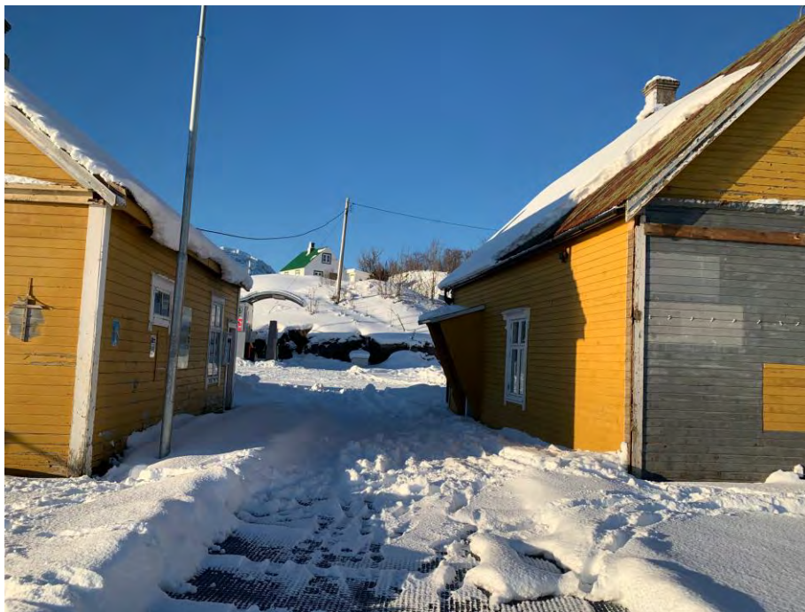
FIGUR 6: PASSASJEN MELLOM KAIBYGGENE
