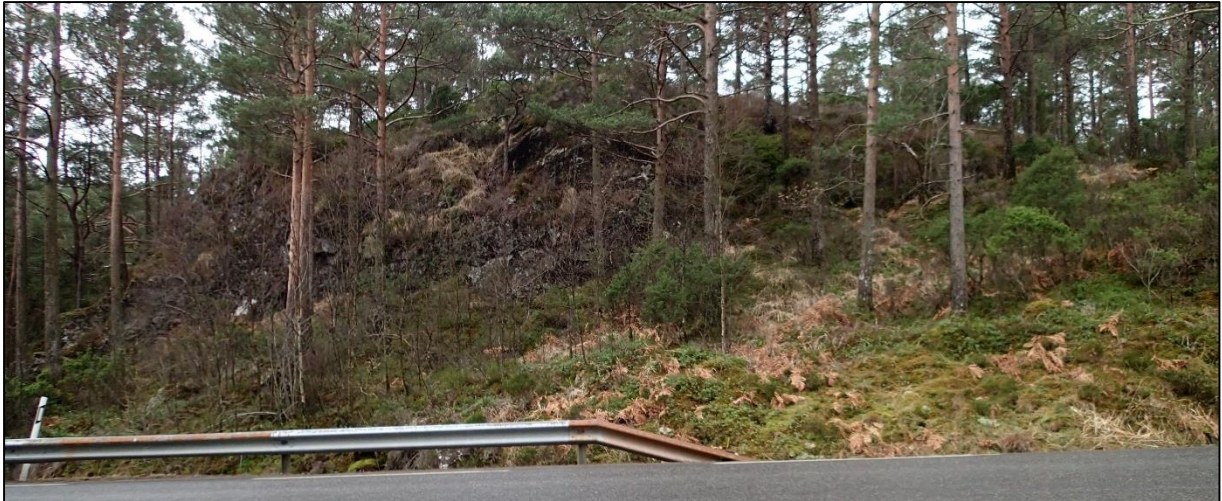
Figur 11: Kalle vest for dagens veilinje som vil medføre skjæringshøyde inntil 12 m ved PEL 8520.
