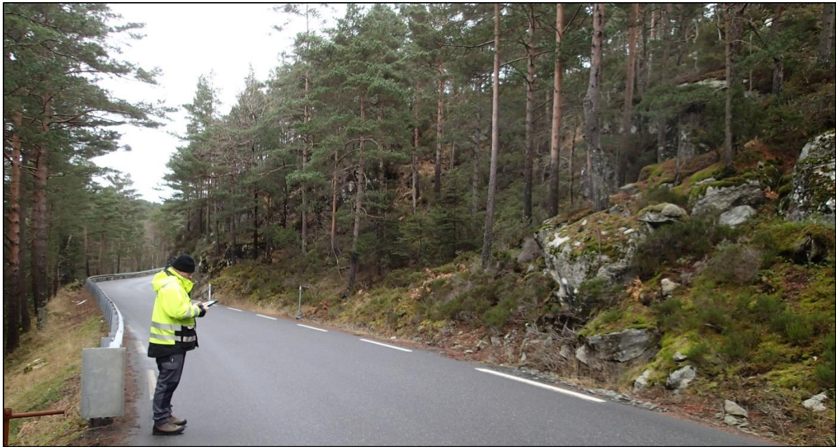
Figur 7: PEL 7940 med lavt sideterreng til dagens vei, men betydelig relieff ved omlegging av vei og skjæring mot terrenget mot øst (høyre)
