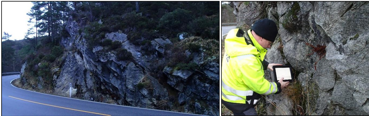
Figur 4: A) Skjæring på østsiden av dagens veilinje ved PEL 7450-7500. B) Måling av sprekkesystemer i granodioritt ved Mjåbekkbrotet.
