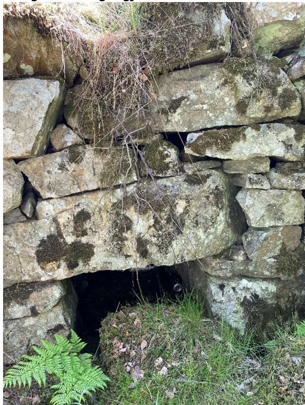
**Figur 8 – Kisteveit av denne sorten fins det fleire av på strekket, gjerne med betongrør på den eine sida av vegtraseen.**
