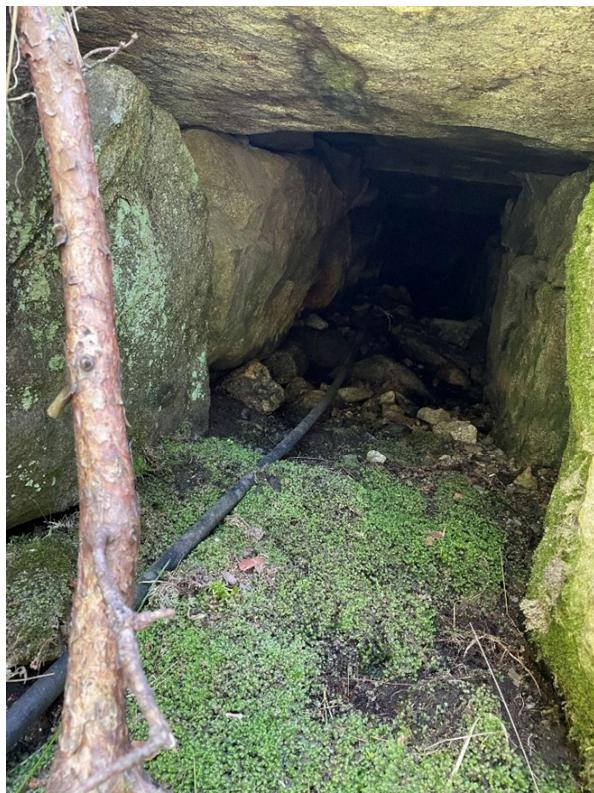
**Figur 7 – Stikkrenne/kisteveit ved avkørysle til eigedom 63/7 og 63/8. Det kan sjå ut som vassforsyning til eigedomane går gjennom.**
