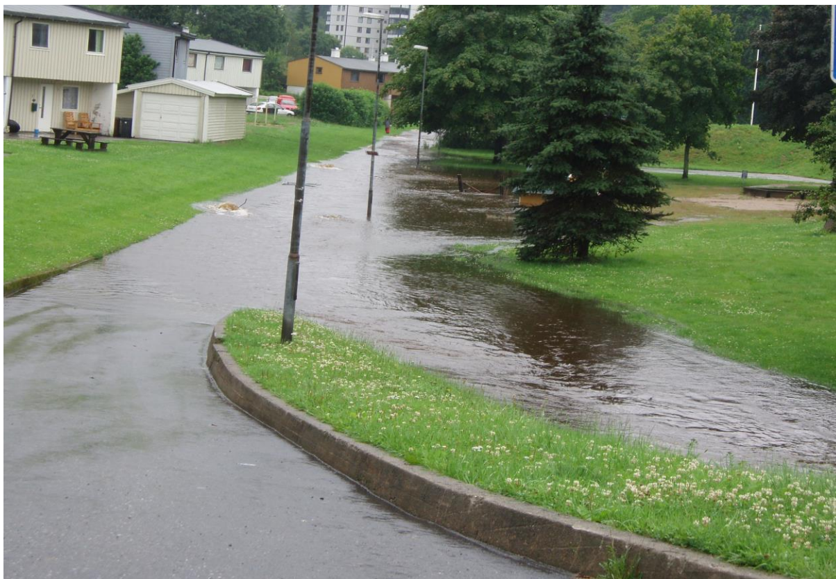
Figur 1. Mølle vannskanalen som flomveg. (foto: Kristiansand kommune)
