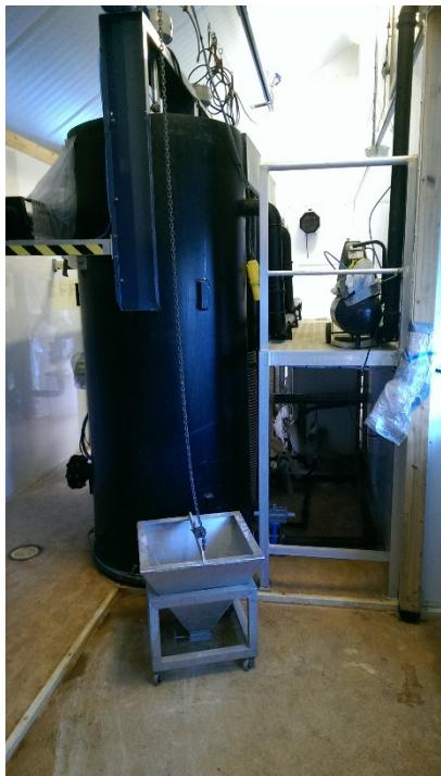
*Figur 3-7: Marmorfilteranlegg ved Uggdal vasshandsamingsanlegg.*
