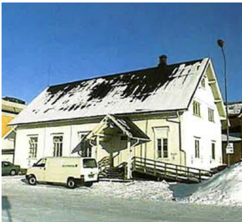
← Losjebygningen i Mo i Rana, som var fredet, ble revet. Verdien av tomten ble inndratt. Foto: Nordland fylkeskommune
